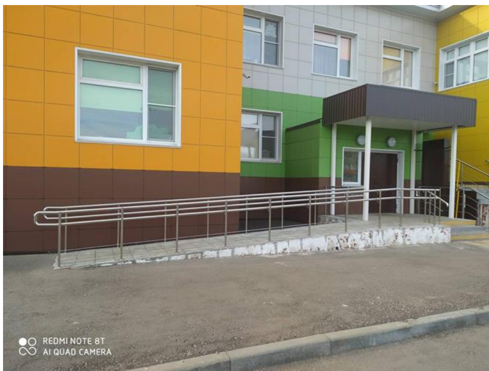
ФОТО № 4 Входная площадка (в здание)
