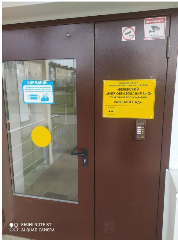
ФОТО № 5 Дверь входная (в здание)
